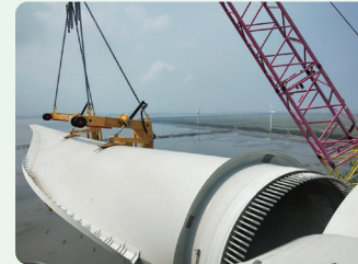
▼ 台泥綠能及星寶電力風機統包工程
