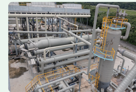
▼ 清水地熱發電廠新建工程
