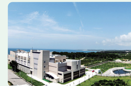
▼ 變電站新建工程
