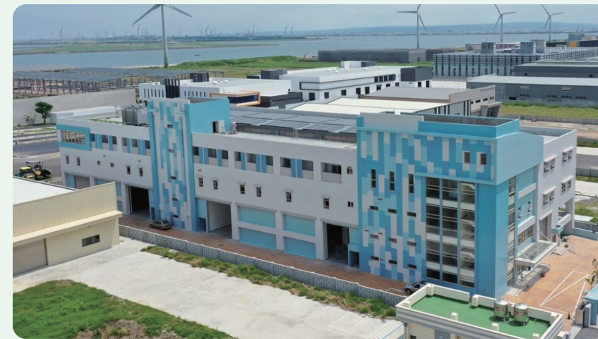
▼ 全台首座再生能源運維中心
