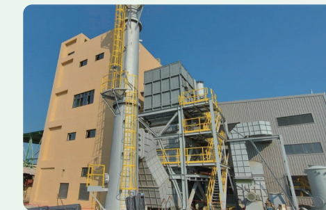
▼ 通霄精鹽廠汽電共生設備汰換新建工程
