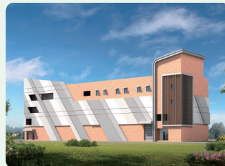
▼ 岡山P/S改建土建統包工程
