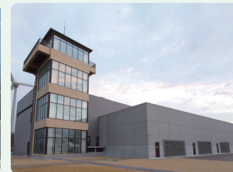
▼ 辰亞能源彰濱太陽光電輸變電統包工程
