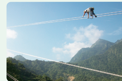
▼ 輸電線路工程
