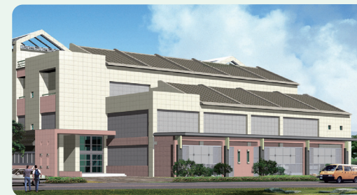
▼ 台電週美一次變電所
