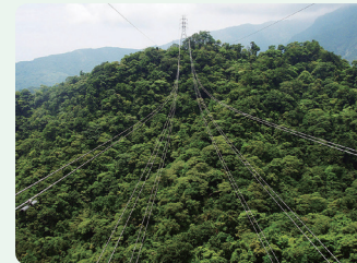
▼ 台電玉山~豐濱輸電線路工程
