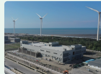
▼ 沃旭大彰化離岸風力陸域輸變電統包工程
