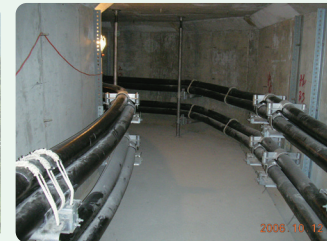
▼ 台電週美~北資輸電線路工程
