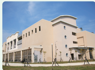
▼ 台電澎湖一次變電所
